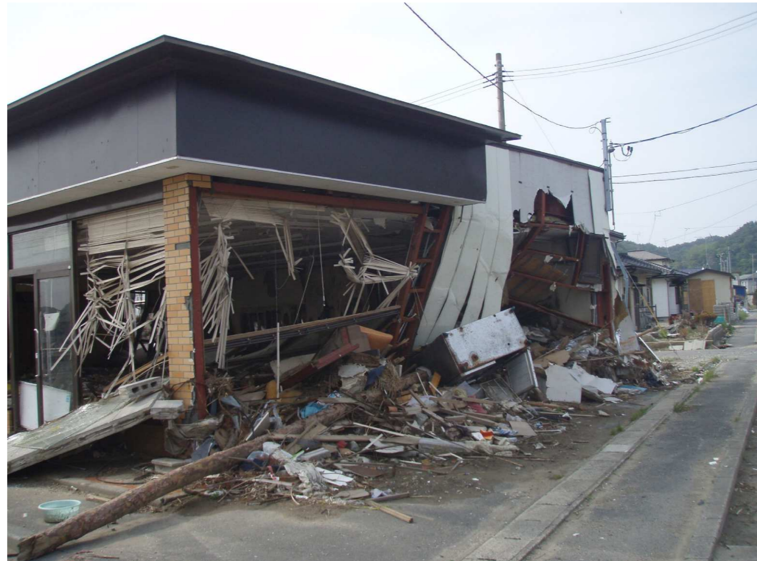
写真は、宮城県東松島市の店舗被災状況
