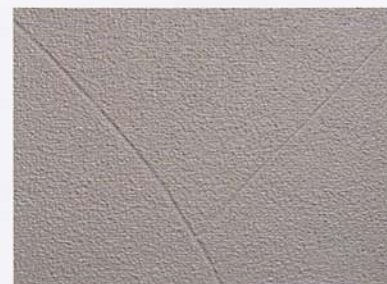
Uカット工法
